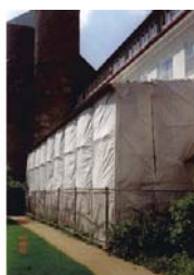
Защитное огорождение на северной стороне галереи.
