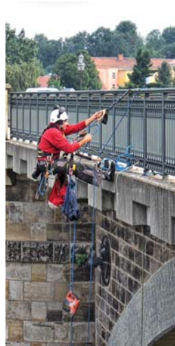
Старинный городской мост в г. Пирна, монтаж измерительных станций.
