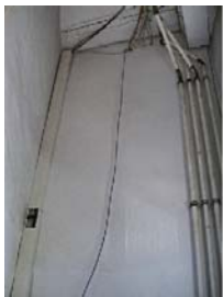
Использование имеющихся кабель-каналов или проёмов в стене и потолочных ригелей
