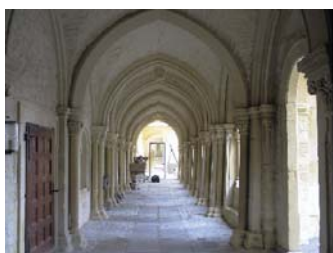
Обходная галерея Церкви Святого михала, г. Хильдесхайм. Вид на северную часть.
